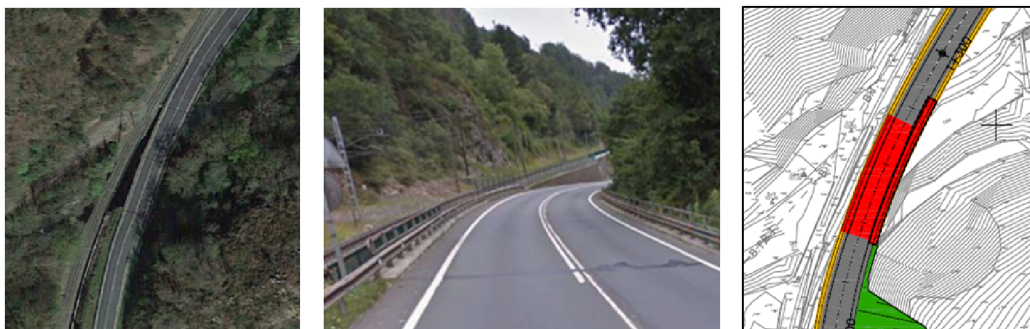
Ilustración 2: Puente sobre el río Oka y ampliación. (Fuente: Plan Especial).
